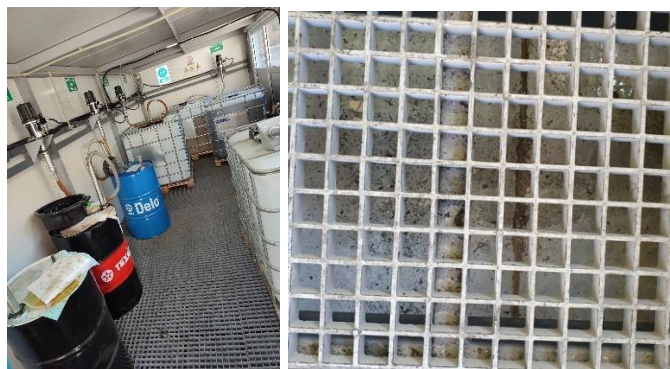
Слика 2 Внатрешен изглед на Станица за складирање на масла и нивно преточување за потребите на сервисна работилница Епирос и приказ на решетка
